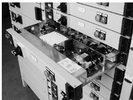
Фиг. E32: Разпределително табло с изтегляеми функционални модули в касети (чекмеджета)
