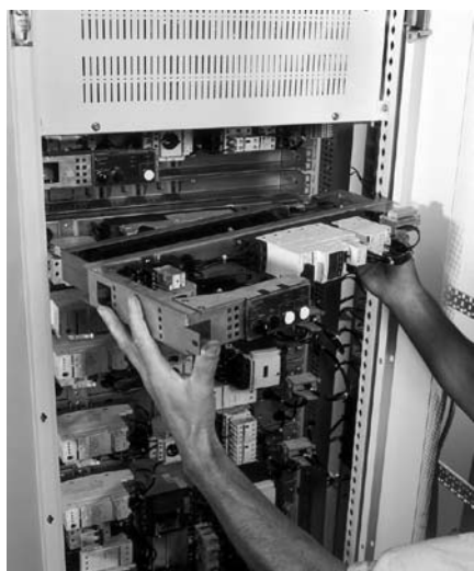
Фиг. E31: Разпределително табло със сменяеми функционални модули
